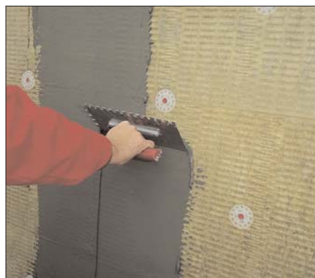
2. ...ha szükséges dübelezzük, és egy újabb ragasztóréteget hordunk fel rá,
