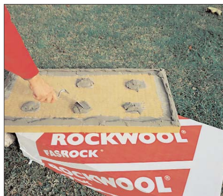
1. A kőzetgyapot lapokat ragasztóval bekenjük,
