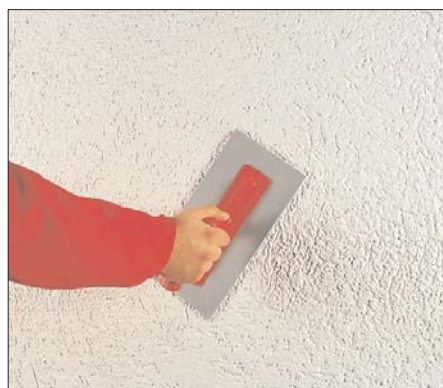
4. ...végül a megszilárdult felületre felhordjuk a fedővakolatot.
