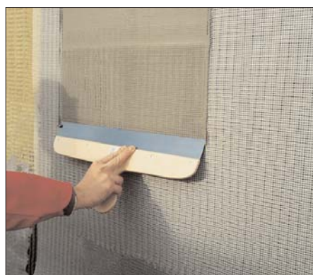
3. ...majd beágyazzuk az üvegszövetet, és elvégezzük a fedővakolat alapozását,
